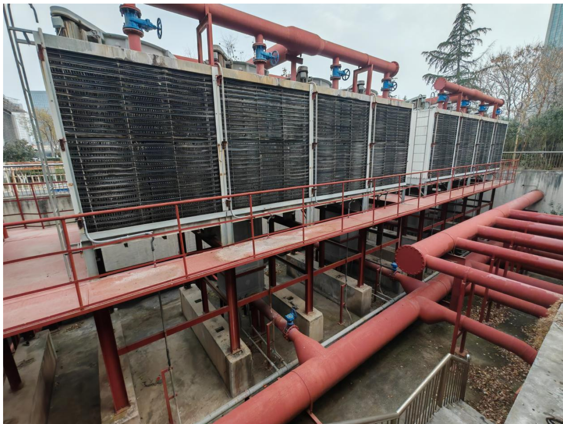
冷却塔安装现状
